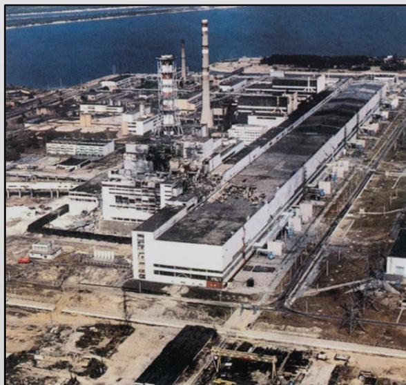
Il test non andò secondo i piani previsti, la potenza della centrale diminuì di una percentuale eccessiva (99%). Per garantire il corretto svolgimento del test fu necessario incrementare lentamente la potenza, ma mentre saliva, si verificò un'impennata inattesa e la chiusura di emergenza non si attivò: il reattore esplose. Le ragioni precise di tale picco di potenza e della successiva esplosione sono ancora ignote.
